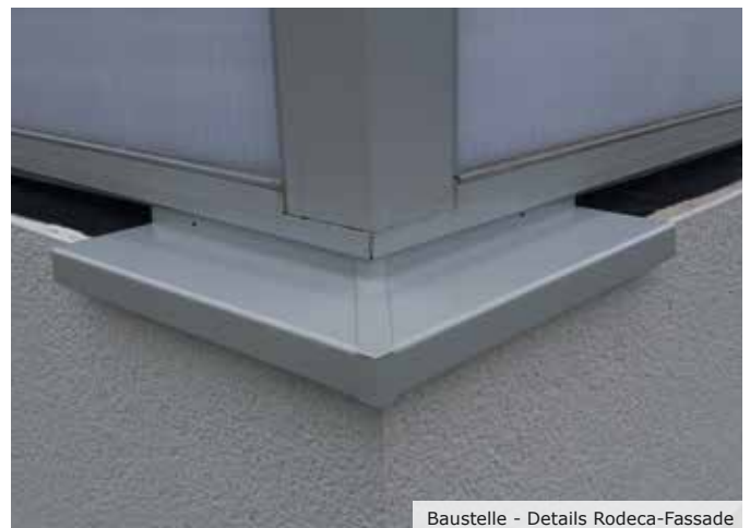
Baustelle - Details Rodeca-Fassade
