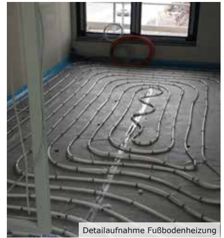
Detailaufnahme Fußbodenheizung
