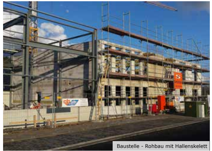
Baustelle - Rohbau mit Hallenskelett
