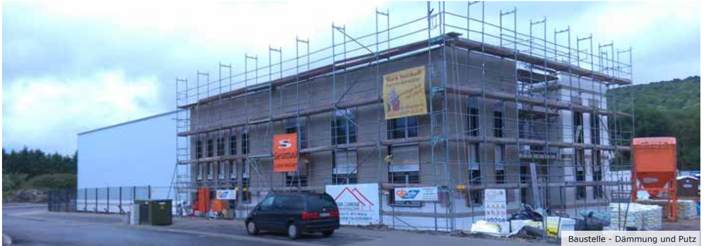
Baustelle - Dämmung und Putz
