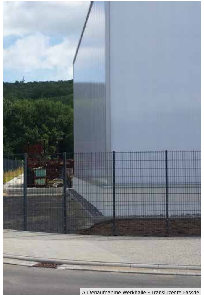
Außenaufnahme Werkhalle - Transluzente Fassade
