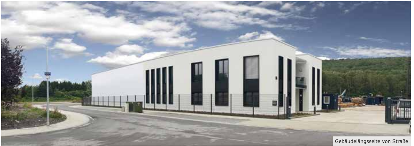
Gebäudelängsseite von Straße
