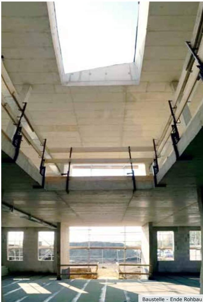
Baustelle - Ende Rohbau
